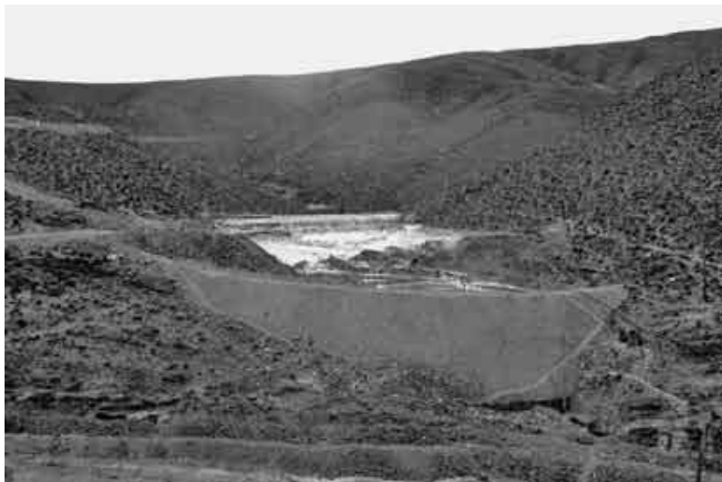
Fig. 1: Presa de colas de la mina Abaroa. Esta foto fue tomada en noviembre de 2003, ocho meses después del evento de inundación. El dique (compuesto de sedimentos claros) fue construido después del evento como parte del programa de remediación. Las colas erosionadas fueron primariamente derivadas del sector inmediatamente detrás del dique.
